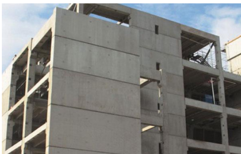
Рис. 3. Сборные бетонные стены
