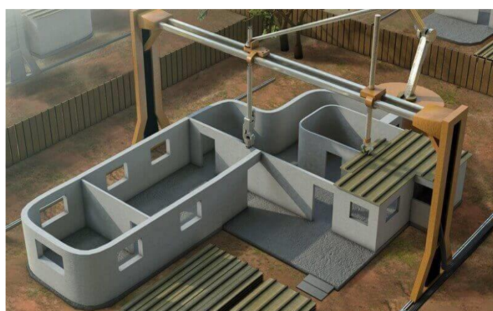
Рис. 4. 3D-печать в строительной сфере
